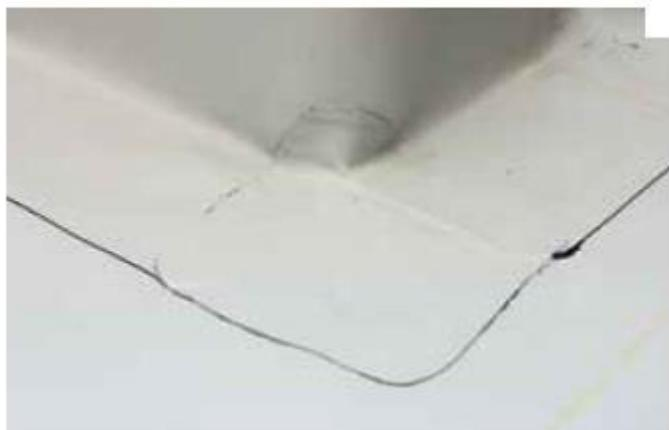
Полученный внешний угол. Подобный узел можно выполнить, используя готовый элемент усиления.
